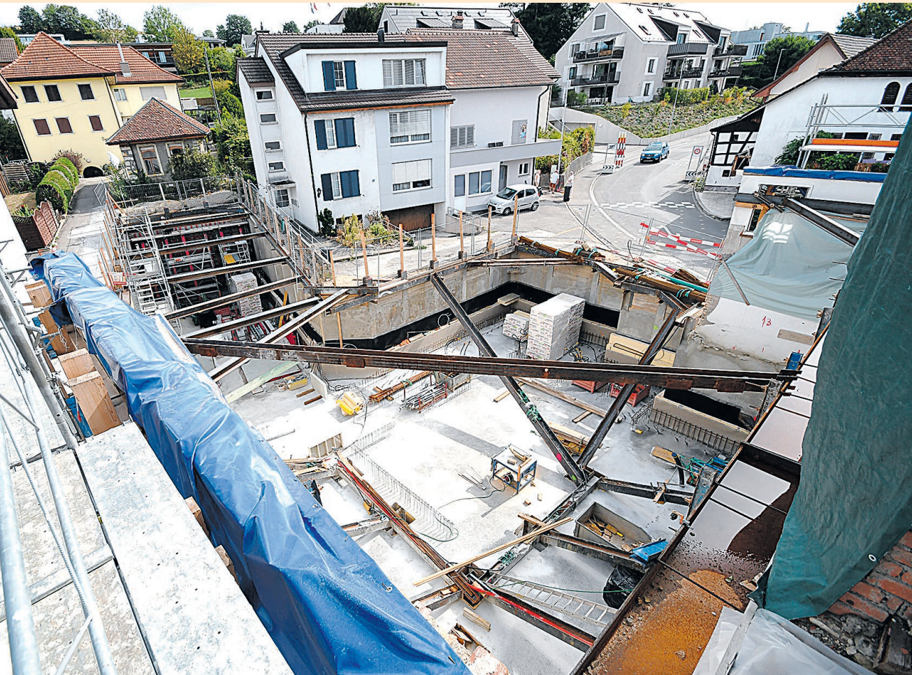
Hinter der Frontfassade des «Haus am Platz» öffnet sich der Blick in die Baugrube. Es handelt sich um das künftige UG des Besucherzentrums Doppeltür mit Veranstaltungsraum und Räumen für die Kino-Inszenierungen. In Hintergrund ist das kleine Gebäude des historischen Mikwe-Tauchbads zu erkennen.
