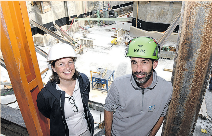
Bauleiterin Karin Schultz und Bauführer Marco Meier auf der Baustelle des künftigen Besucherzentrums Doppeltür.
