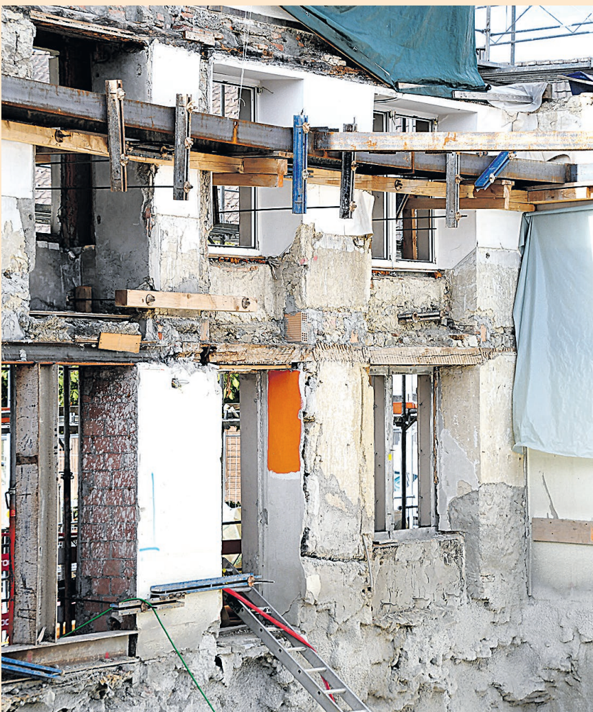
Der Blick an die Rückseite der Frontfassade zeigt einerseits, wie massiv die Konstruktion verstärkt und gesichert werden musste, damit sie im Zuge der Bauarbeiten keinen Schaden erleidet. Andererseits sind an dieser Rückseite auch verschiedene Baustile der Vergangenheit abzulesen.
