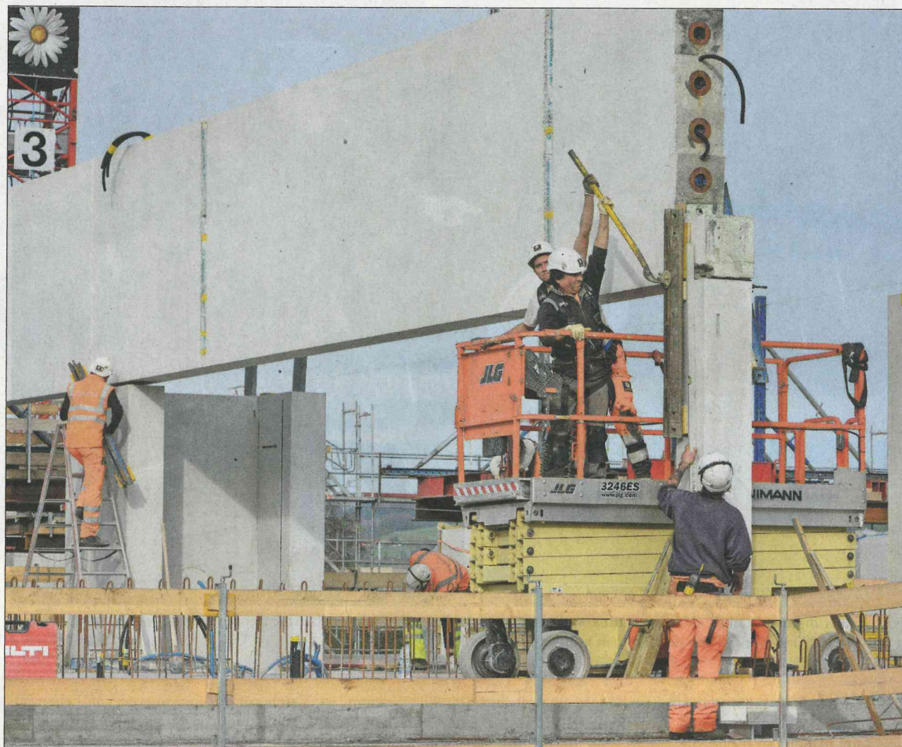
Die Bauarbeiter haben auf dem Campus Sursee trotz grosser Unterstützung von starken Maschinen noch Handarbeit zu leisten. Sie montieren die Träger der Schwimmhalle.
